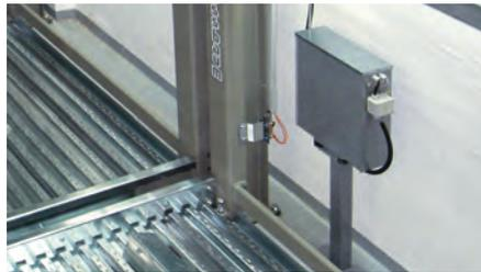
mit Hydraulikverrohrung und Verdrahtung zur Anlage. (Das Unterölaggregat ist dank der Motor-Pumpen-Kombination, welche Schall absorbiert und gedämmt in Öl liegt, gedämpft).
