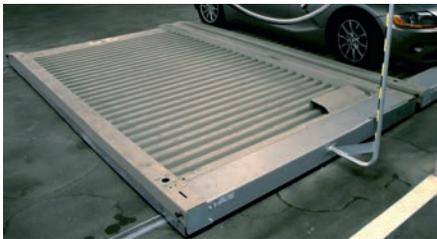
Plattformen mit Seitenwangen und Fahrschienen werden bei der Montage der Schiebeplattformen in der Tiefgarage vor Stützen direkt am Boden verdübelt. Achtung: Bei Anordnung von mehreren Längspaletten nebeneinander ist zu beachten, dass von einem Bedienelement aus nur die Plattformen bewegt werden dürfen, die sich in einem Umkreis von 20m (s.h. DIN EN 14010, Artikel 5.8.4.2) befinden, damit eine optische Überwachung der Bewegung möglich ist.
