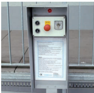
Berlinsteuerung mit Wetterschutzgehäuse und Ständer
